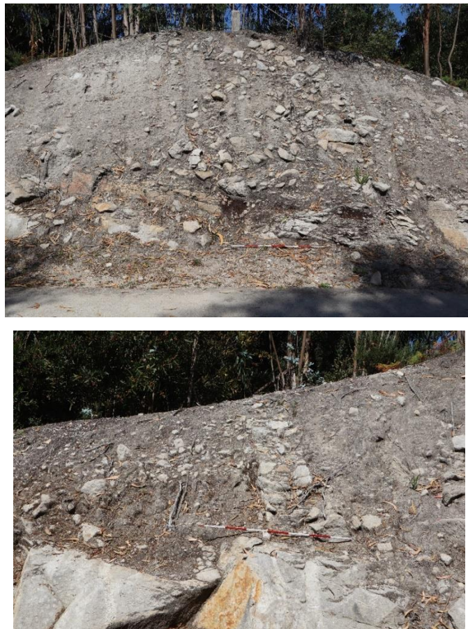
Figura 2. Aspeto de uma muralha (?) da Idade do Ferro (em cima) e de outra estrutura (em baixo).
